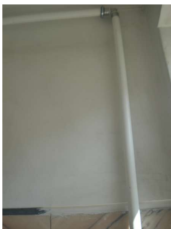
Coluna montante de água, R. Cor. Marques Leitão, 7
