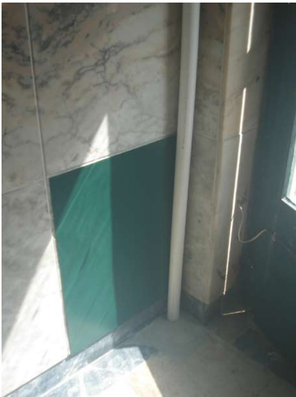
Coluna montante de água, R. Cor. Marques Leitão, 3
