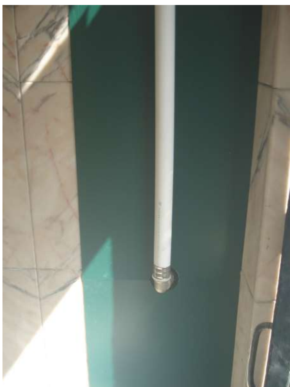
Coluna montante de água, R. Cor. Marques Leitão, 7
