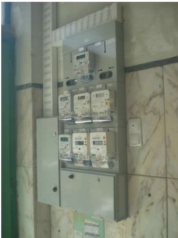
Coluna montante de eletricidade
