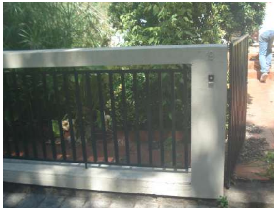
Depois da execução das obras de recuperação
