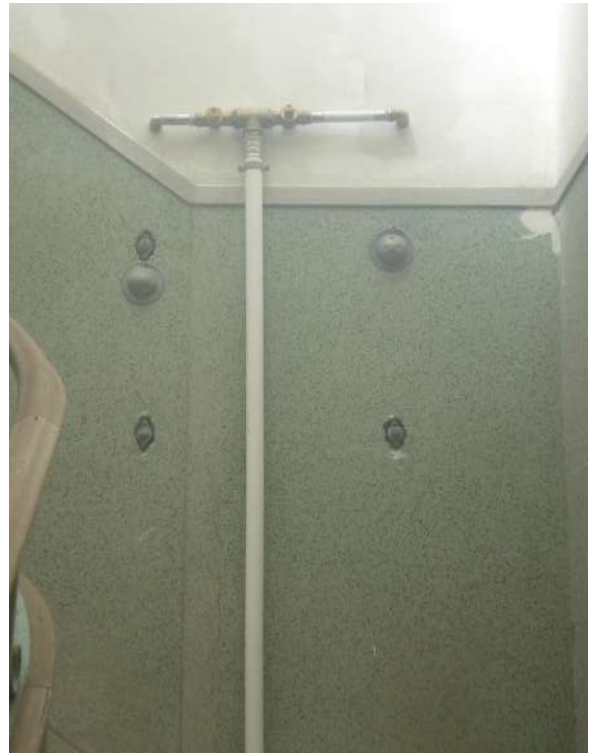
Coluna montante de água, R. Cor. Marques Leitão, 3
