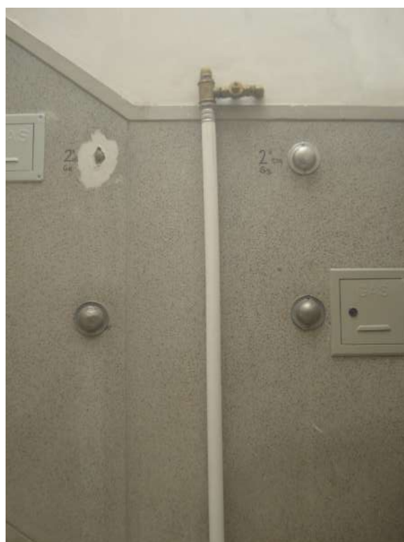
Coluna montante de água, R. Cor. Marques Leitão, 5
