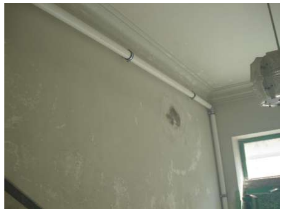
Coluna montante de água, R. Cor. Marques Leitão, 5
