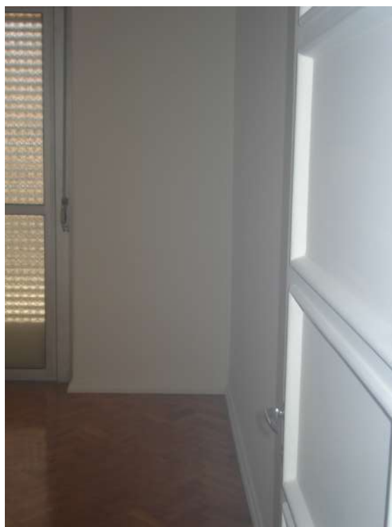
Depois da execução das obras de recuperação
