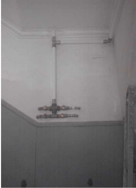
Coluna montante de água, R. Cor. Marques Leitão, 3
