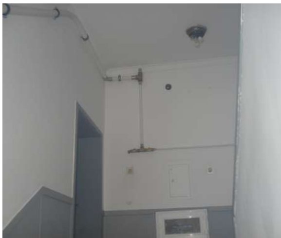
Coluna montante de água, Av. Rio de Janeiro, 34
