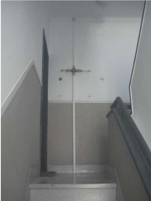
Coluna montante de água, Lg. Ribeiro Cristino, 1
