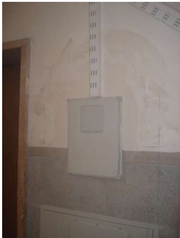
Coluna montante de eletricidade
