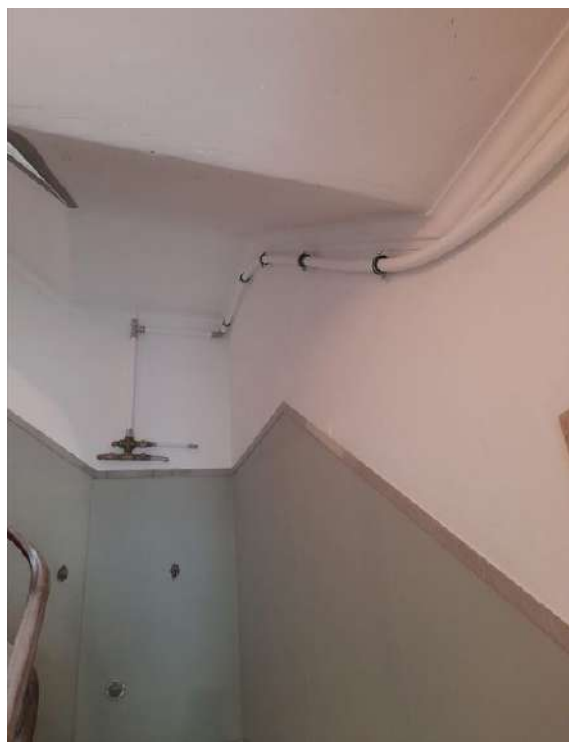
Coluna montante de água, R. Cor. Marques Leitão, 1
